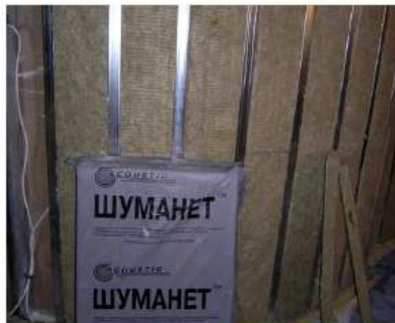
Плита звукопоглощающая Шуманет БМ Профиль стоечный Лист ГКЛ/ГВЛ
